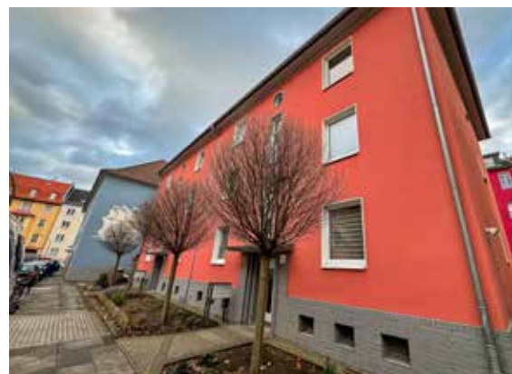
Die an die Lebenshilfe e.V. vermieteten Häuser Nettelbeckstraße 4 und 4a stehen für das Projekt ADLeR zur Verfügung.
