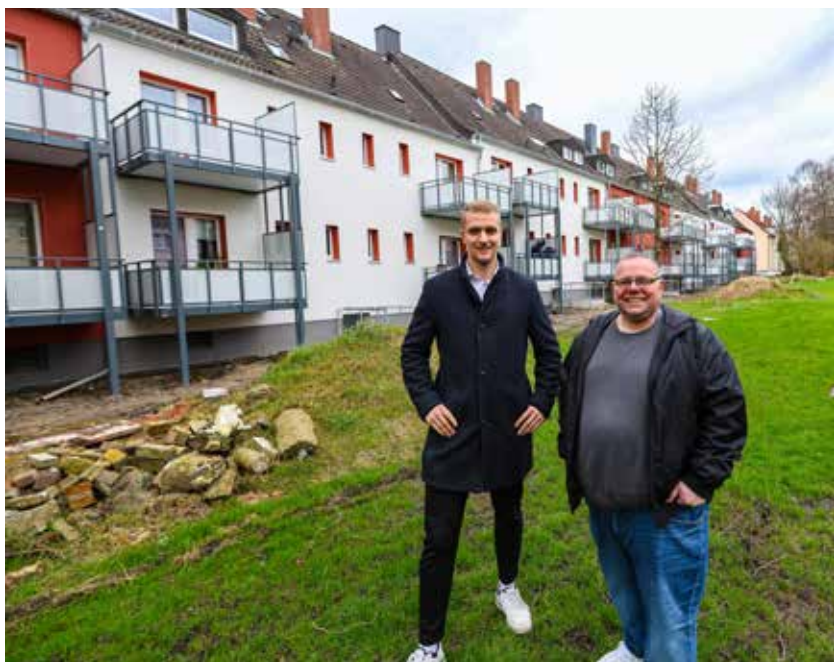
Die ersten 51 Häuser sind geschafft: DOGEWO21-Bauleiter Philipp Heilmann (l.) und Tim Haverkamp.
