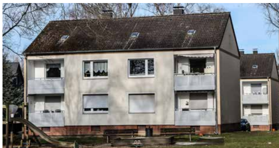
DOGEWO21 modernisiert und stockt zwei Häuser in Aplerbeck auf.
